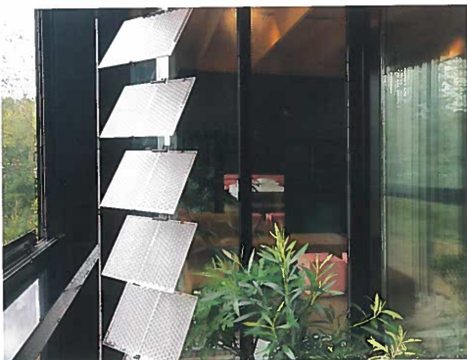
ENERGIEOPWEKKENDE ZONWERING IN DE MOCK-UP IN BLIIDORP
